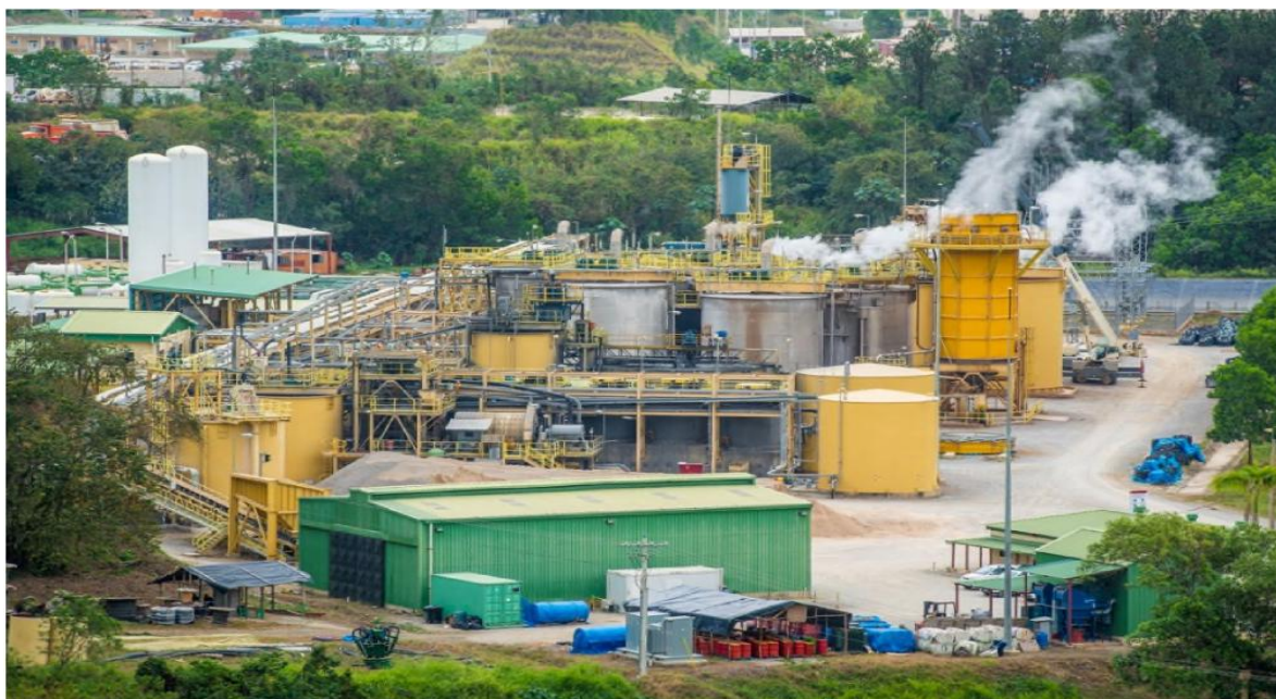
Las Lagunas Albion/CIL Plant, Dominican Republic
